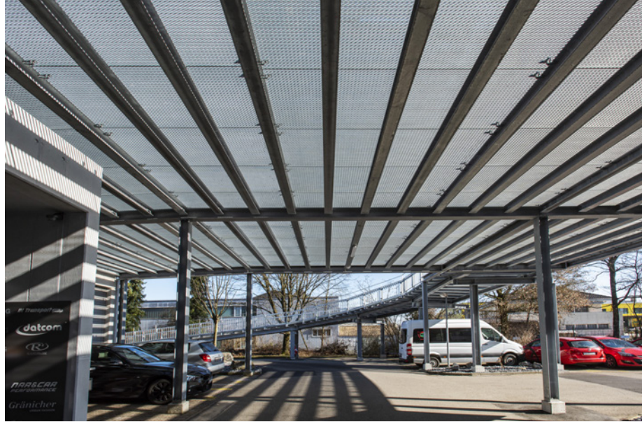
Die Rampe und das Parkdeck können mit einem Raddruck von 900 kg belastet werden.
