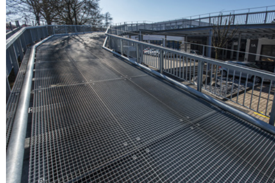
Der Schweisspressrost ist an jedem Kreuzpunkt verschweisst. Er hält aufgrund seiner Machart den stärksten mechanischen Belastungen und Erschütterungen stand.
